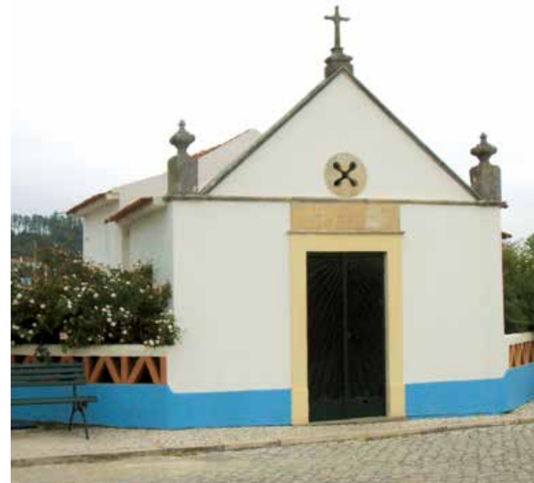
Fig.20 – Capela de Nossa Senhora do Caminho. Fotografia: ADF/José Paulo Ruas
